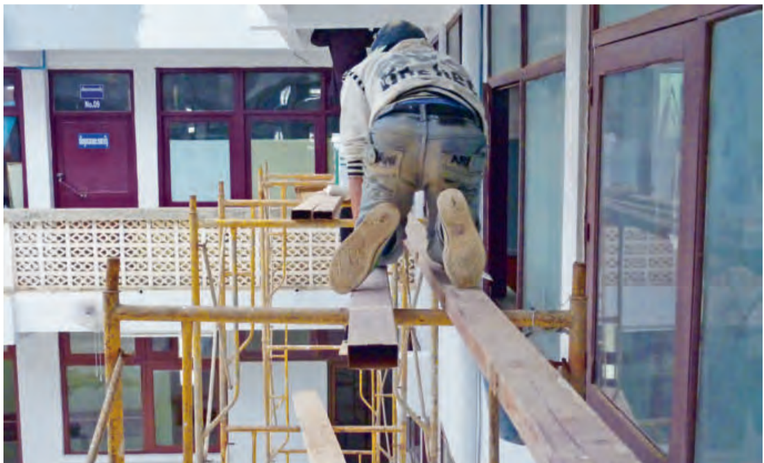
Die Bauarbeiterinnen und Bauarbeiter in Laos müssen schwindelfrei sein. ພະນັກງານກໍ່ສ້າງຢູ່ລາວຕ້ອງເປັນຄົນທີ່ບໍ່ຢ້ານຄວາມສູງ
