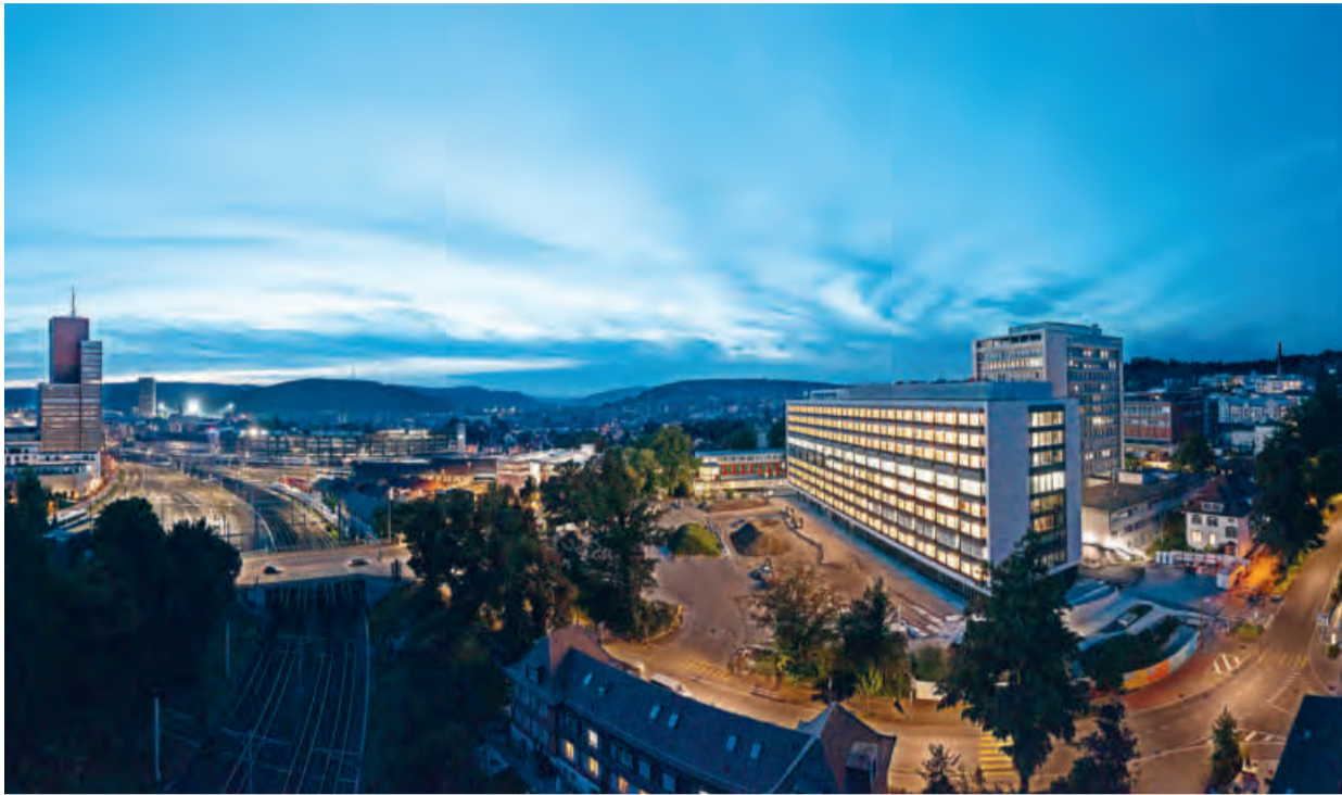
Der Neubau ist bereits in Betrieb. Nur der Park muss noch bepflanzt werden. ອາຄານຫລັງໃໝ່ກໍ່ໃຊ້ໄດ້ເປັນທາງການແລ້ວ ເຫຼືອພຽງແຕ່ພາກສ່ວນສວນຍັງຕ້ອງປູກເຄື່ອງປູກໃສ່
